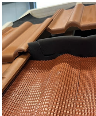
Dichtmaterial anbringen
