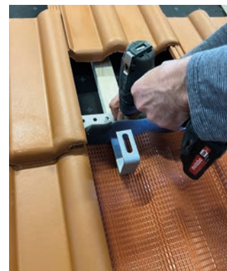
Dachhaken H36 montieren - fertig.
